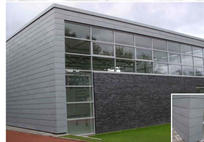
Sporthalle, Großrauten, Zink vorbewittert
