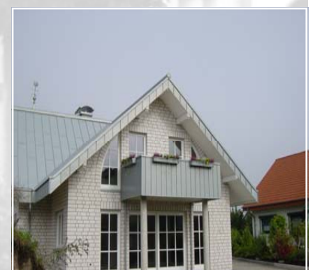
Wohnhaus, Dach in Stehfalztechnik
