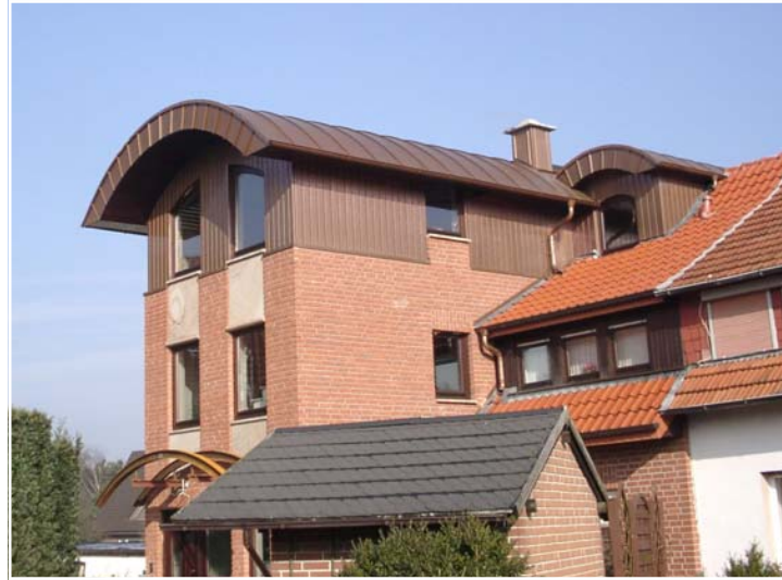
Bürohaus, rundgebogene Scharen
