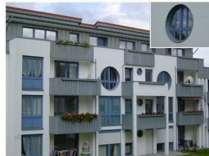
Mehrfamilienhaus, Balkone in Steckfalzpaneel
