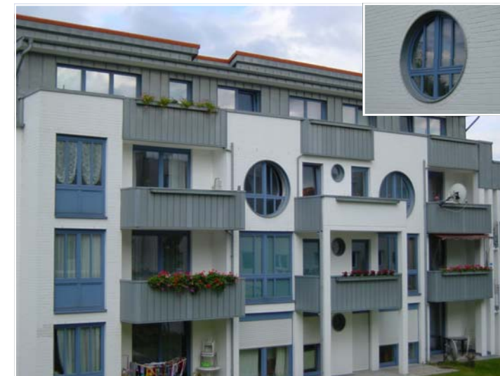
Mehrfamilienhaus, Balkone in Steckfalzpaneel
