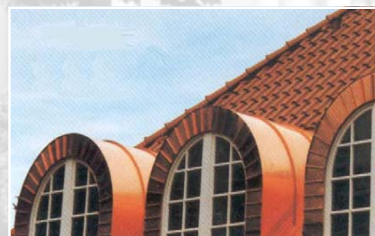
Dachgaube mit rundgebogenen Kupfer-Scharen
