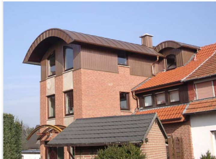
Bürohaus, rundgebogene Scharen
