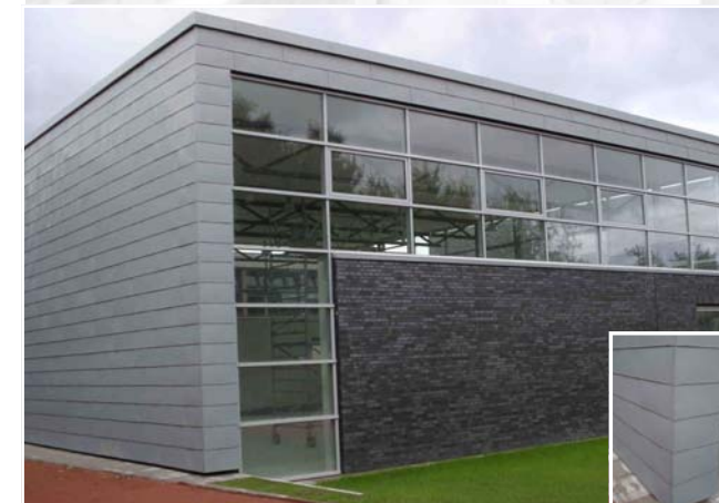
Sporthalle, Großrauten, Zink vorbewittert
