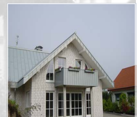
Wohnhaus, Dach in Stehfalztechnik
