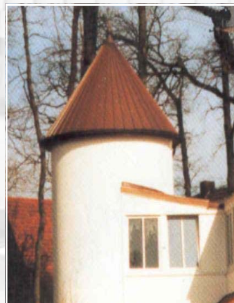
Turmdach, konische Scharen
