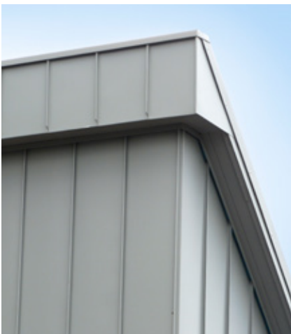
Blende und Fassade in Winkelstehfalz
