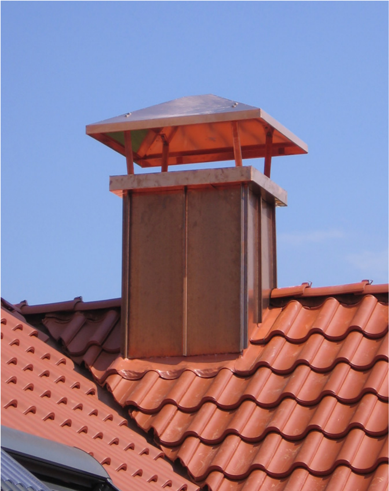
Kaminverkleidung in Kupfer, Stehfalz mit eckiger Kaminhaube
