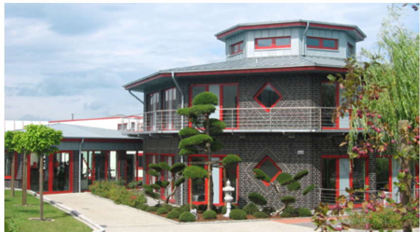
Dachfläche in Doppelstehfalz
